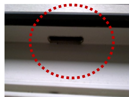
Afbeelding ontwatering sleuf binnenzijde
